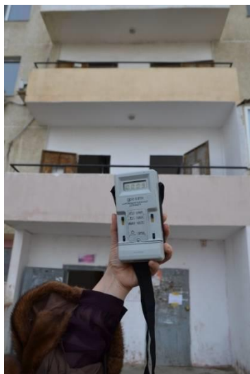
Рисунок 2 – Проведение измерений в 16-этажном доме в микрорайоне Алмагуль на проспекте С.Бейбарса, дом 17
